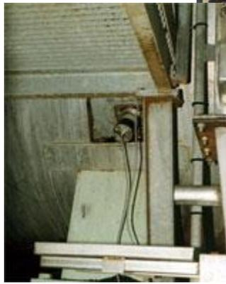
Sonde FSH (190°C dans sécheur de protéines animales)
